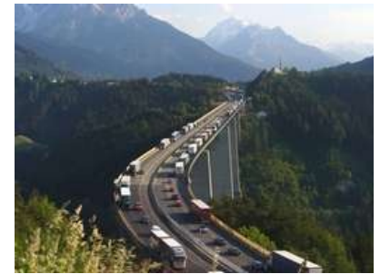
Brennerautobahn, Europabrücke (©Lars Keller)
